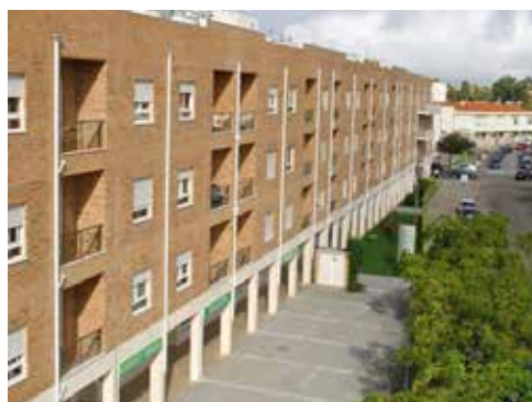
Edifício Hospital da Misericórdia
