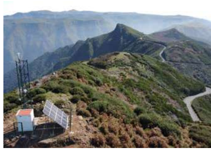
Vista do site de um sistema de deteção precoce de incêndios florestais implementado pela LEITEK na Ilha da Madeira.
